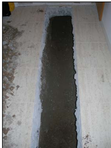
Rasa de l'interior de l'edifici
