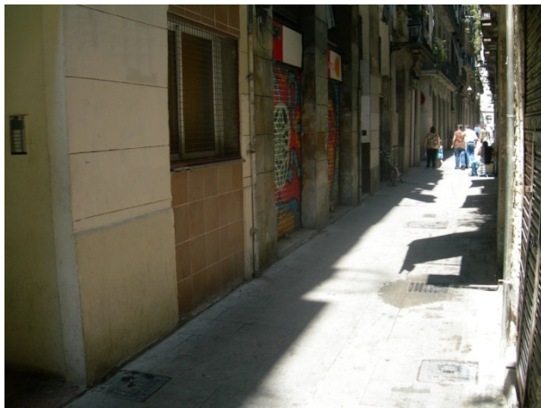
3. Vista exterior del carrer Còdols 14 bis.
