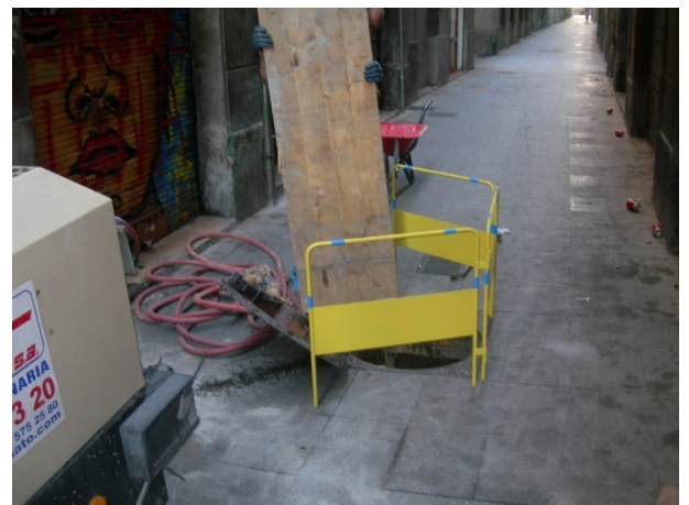
4. Vista exterior del carrer Còdols 14 bis.
