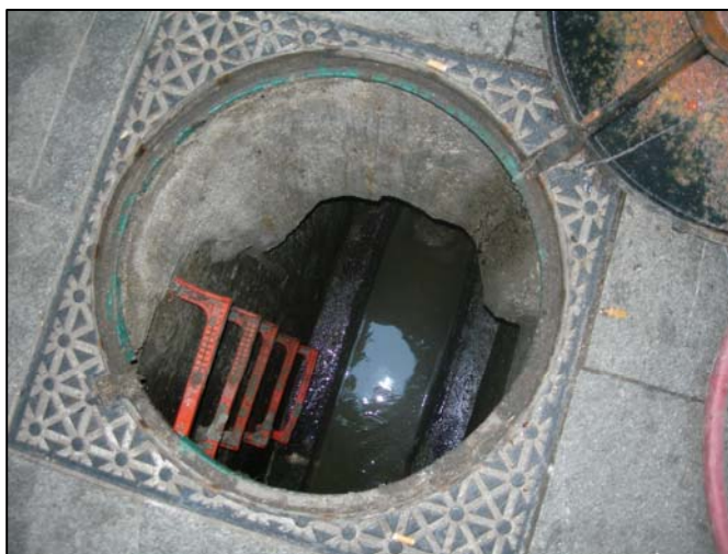
Vista de la claveguera exterior.
