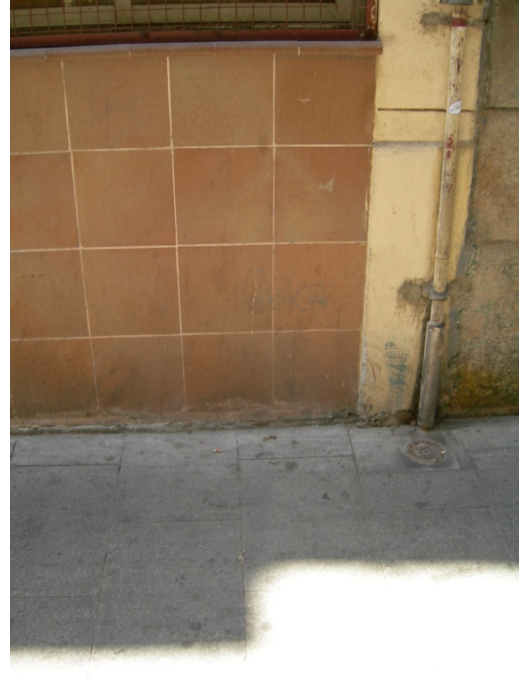
2. Vista exterior del carrer Còdols 14 bis.
